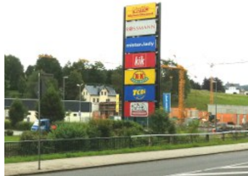
Das neue Göltzschtalzentrum im Bau
